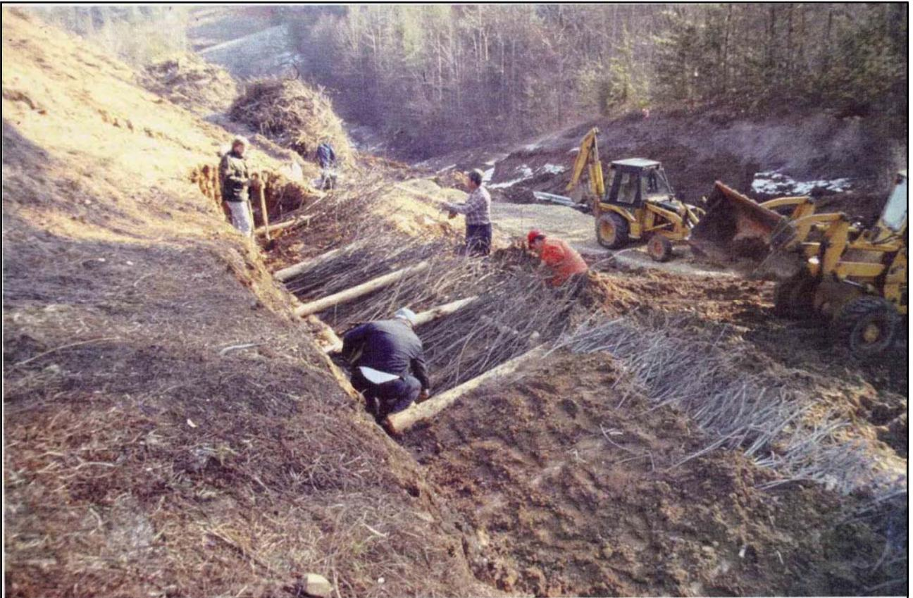
Figura 3. Instalación de un entramado de madera, fases finales.
